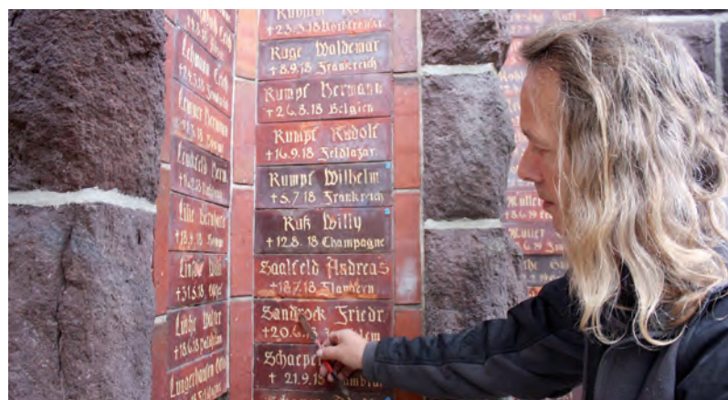
Reinhard Görlach von der Fa. Hopp beim Auftragen des Ergänzungsmörtels auf die Namensplatten. (Foto: Ilona Bergmann, Pressestelle)
