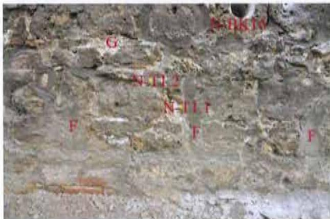
Bild A2.66: Übersicht zum Entnahmebereich der Teilproben N-T1.1 und N-T1.2
