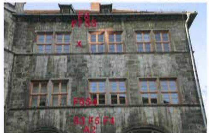
Bilder A1.57 und A1.58: Übersichten zur Lage der Probenahmestellen an der Südfassade des Rathauses
