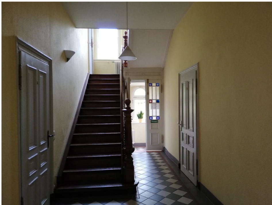
Abbildung 6: Innenansicht - Treppenaufgang Obergeschoss
