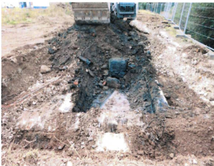
Abb. 4: Aushubarbeiten in SZ-A
