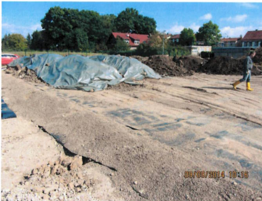
Abb. 9: Bereitstellung kontaminierter Aushubmaterialien auf der Bereitstellungsfläche
