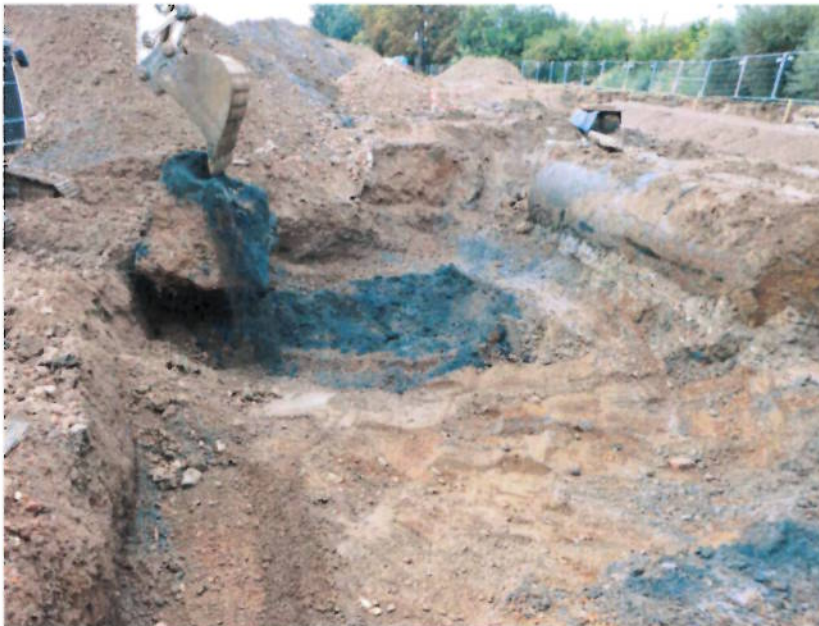
Abb. 5: Aushub in SZ-B (hier Rückbau Einzelfundament, rechts Lagertank)
