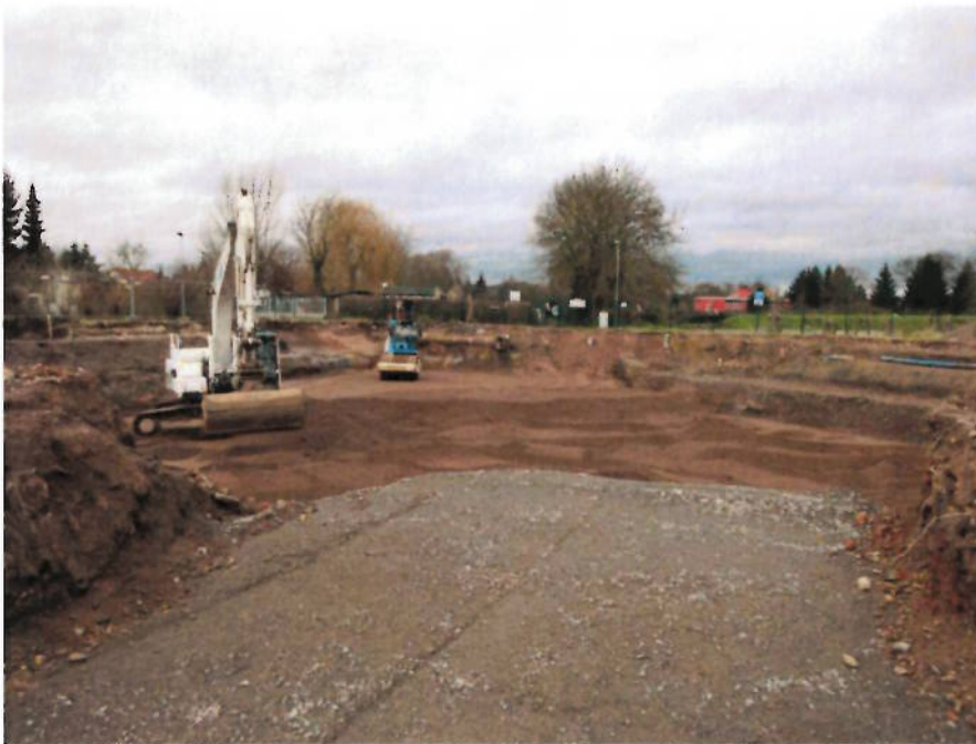
Abb. 10: Lageweise Rückverfüllung und Verdichtung der Baugruben
