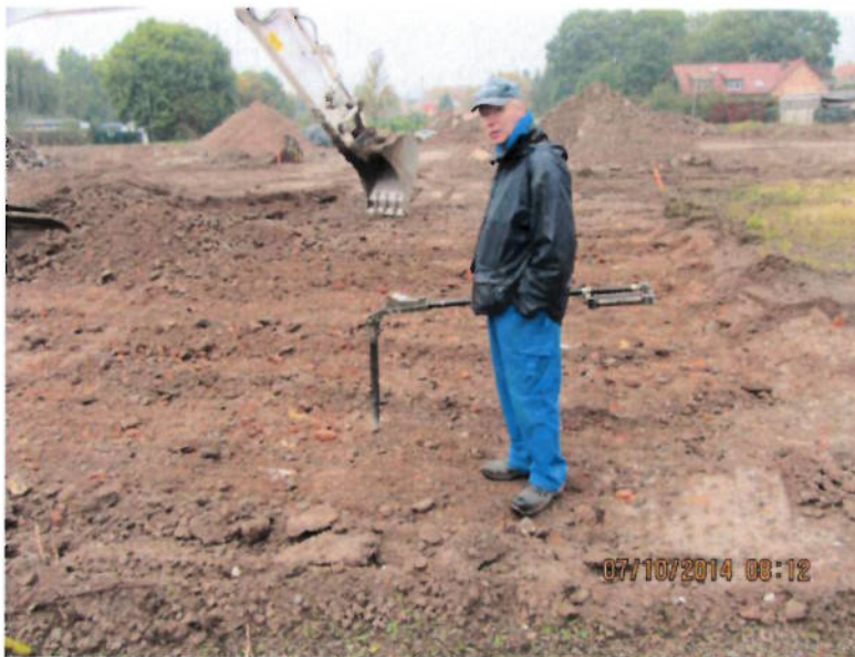
Abb. 8: Begleitung der Aushubarbeiten durch den Kampfmittelsachverständigen
