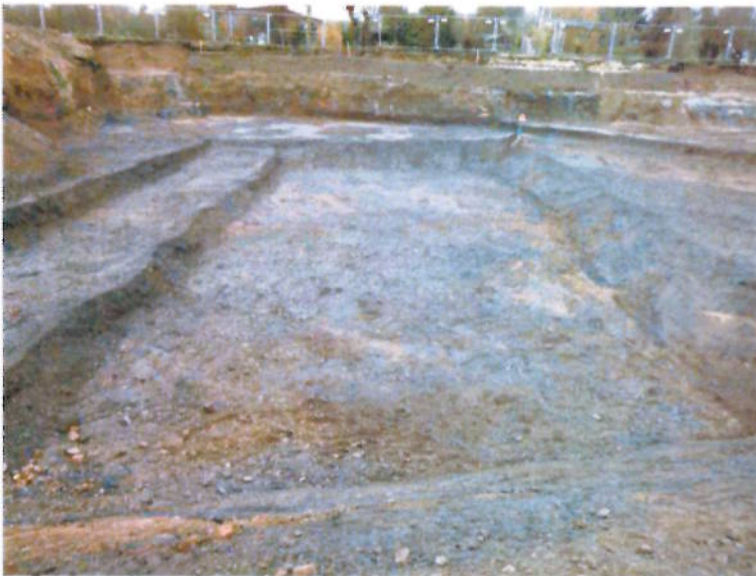
Abb. 7: Erweiterter Aushub in SZ-B
