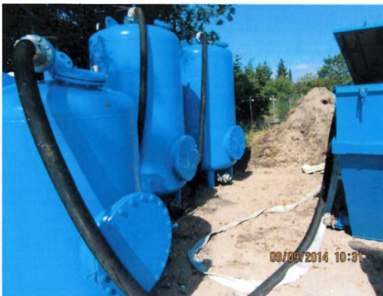
Abb. 11: Grundwasseraufbereitungsanlage mit Vorlage, Kiesfilter und zwei Aktivkohlefiltern
