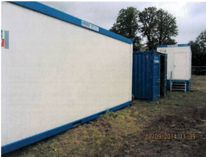
Abb. 2: Elemente der Baustelleneinrichtung (Büro-/Materialcontainer, S/W-Anlage)
