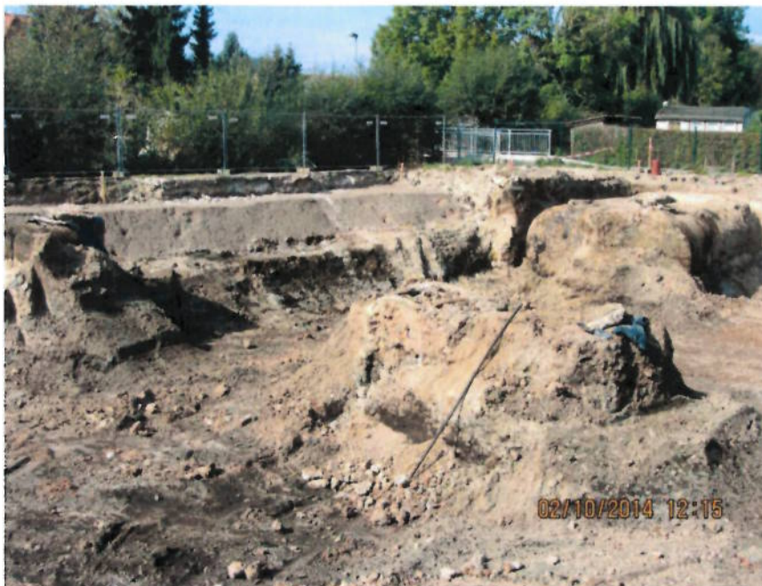
Abb. 6: Freigelegte Lagertanks in SZ-B
