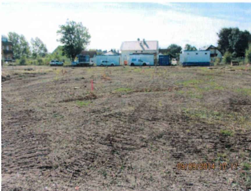
Abb. 3: Absteckung der Sanierungszonen mit Pflocken
