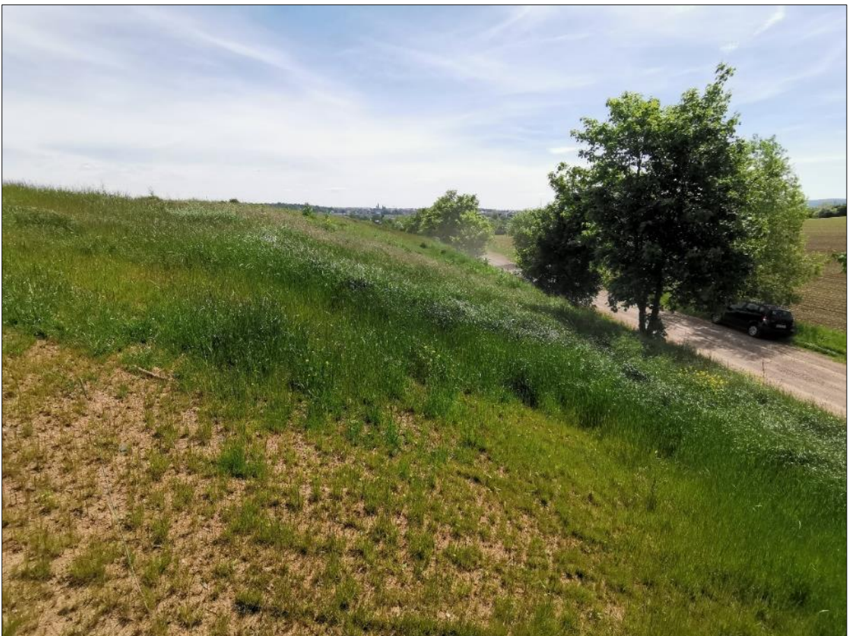
Abb. 13 aktuelle Biotopausprägung an der südlichen Deponieböschung, 06/2021
