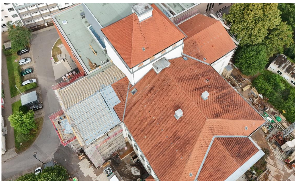
Theaterbaustelle außen (Foto: Stadtverwaltung Nordhausen)
