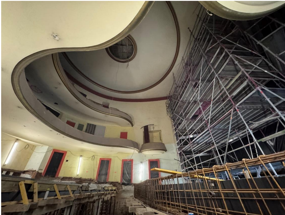
Theaterbaustelle innen (Foto: Stadtverwaltung Nordhausen)
